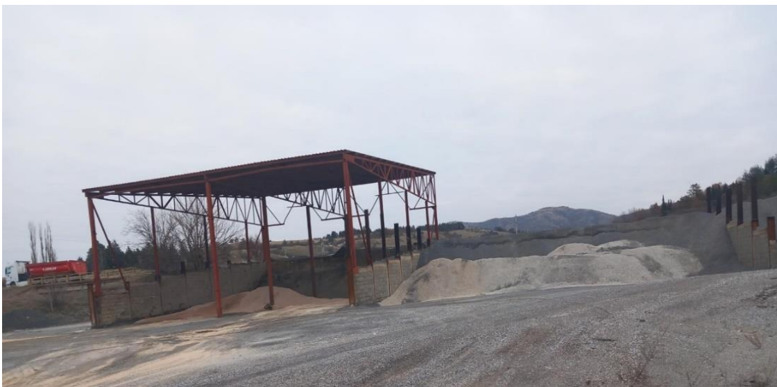
Слика бр. II.13 - Покриен и откриен склад за фракции од камен материјал (ризла)
