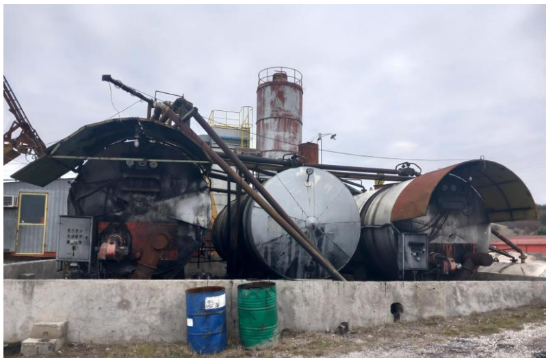
Слика бр. II.6. – Три надземни термоцистерни за складирање битумен во втечната состојба, секоја со капацитет од по 35 t. Термоцистерните се загреваат со пламеници преку греен медиум терманол
