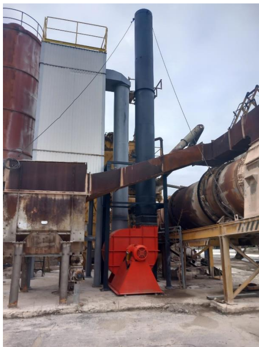
Слика бр. II.9. - Изведен филтерски систем за отпашување на димни гасови
