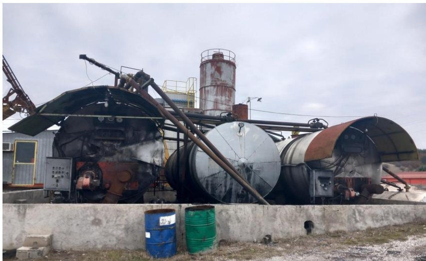
Слика бр. 6. – Три надземни термоцистерни за складирање битумен во втечната состојба, секоја со капацитет од по 35 t. Термоцистерните се загреваат со пламеници преку греен медиум терманола
